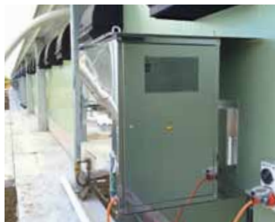
Montaż na zewnątrz
