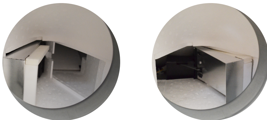
Rys. 13. By-pass otwarty / by-pass zamknięty.
